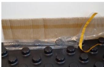
**Die selbstklebende Folie des Randdämmstreifens zwischen der ersten und zweiten Noppenreihe einkleben.**
